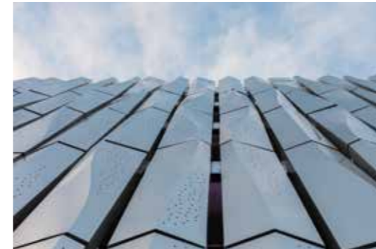
Dockan, Västerås. Beställare: Västerås stad Foto: Markus Linderöth
