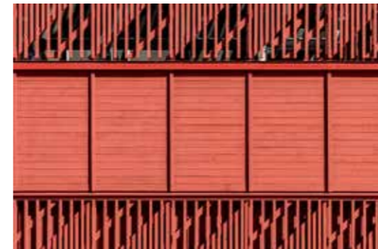
Sigtuna Stadsängar energicentral. Beställare: E.ON Energiösnings AB Foto: Tim Meyer
