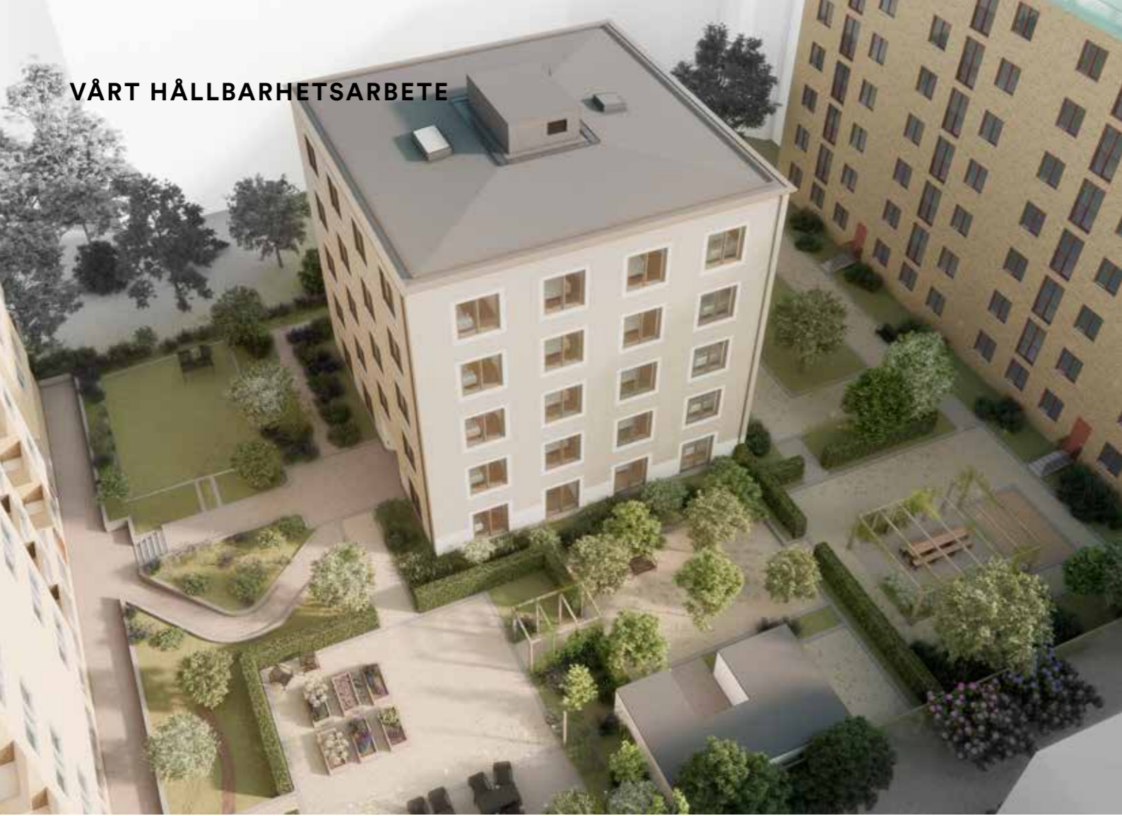
Illustration av kv Nebulosan, Stockholm Flerbostadshus med fasad av återbrukat tegel och stomme av volymelement i trä.
