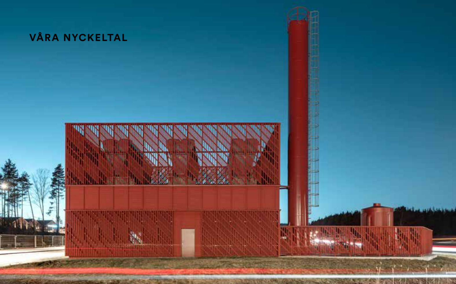
Sigtuna Stadsängar energicentral Foto: Tim Meier
